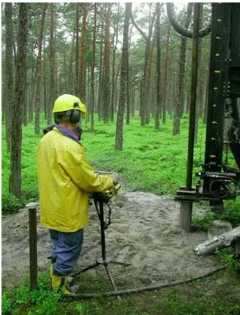
Etablering av grundvattenrör med hjälp av borrhandsvagn.
