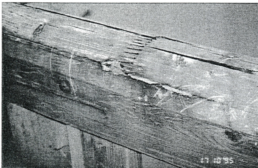
FIGUR 3. Fruktkropp av en rötsvamp växande på lärkvirke i en brokonstruktion i Tyskland. Fotot taget tre år efter brons färdigställande.
