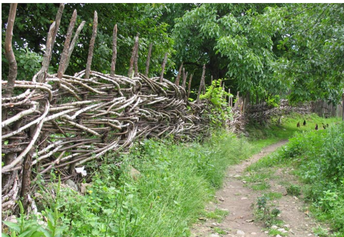
Hägnader, gärdesgårdar och staket är så gott som alltid gjorda av trä. De uppvisar en stor variation alltifrån tröpallisader till flätgärdesgårdar. Här är några exempel på hägnader som byggts med omsorg. Den övre bilden visar ett omålat plank och den nedre en flätgärdesgård (notera de lösgående hönsen).
