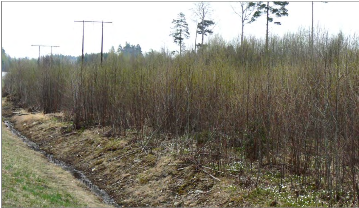
Figur 6.1 Igenväxande sly i kraftledningsgata. (Foto J-O Helldin)
