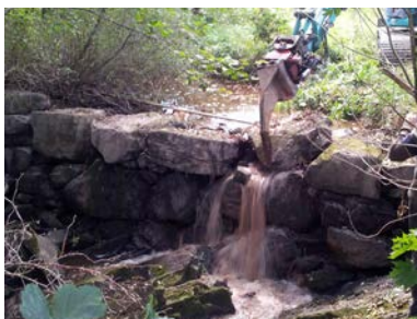
Figur 23. En fellagd vägtrumma byts mot en bro. Åtgärden är utförd av Sveaskog inom ReMiBar -projektet.
