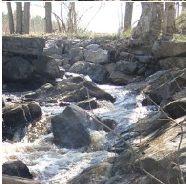
Figur 24. Några år efter att Trafikverket hade åtgärdat en fellagd trumma kunde ett vandringshinder längre nedströms åtgärdas av Länsstyrelsen. Stendammen var från senare delen av 1800-talet och revs ungefär till hälften för att tillgodose krav på att en del av den kulturhistoriska miljön skulle kvarstå.
