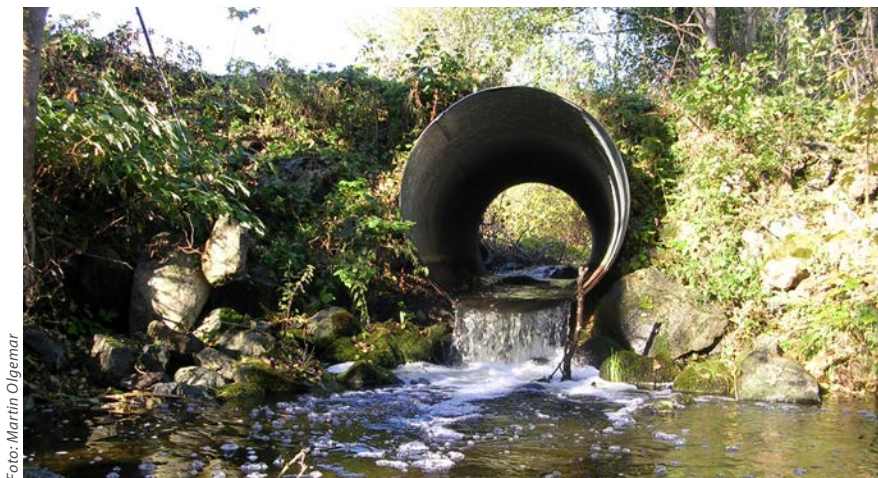
Figur 8. Fellagda trummor utgör ett vanligt vandringshinder idag vid vattenpassager, såväl på statliga som ickestatliga vägar. Fisk och botten djur kan inte passera, vilket ofta hindrar fisk att nå lekplatser där de parar sig.
