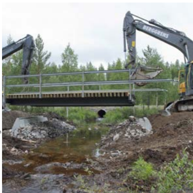
Figur 23. En fellagd vägtrumma byts mot en bro. Åtgärden är utförd av Sveaskog inom ReMiBar -projektet.
