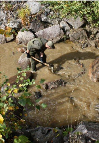
Figur 4. En av Trafikverkets miljöspecialister fördelar grus och sten på botten för att skapa bra lekbottnar.
