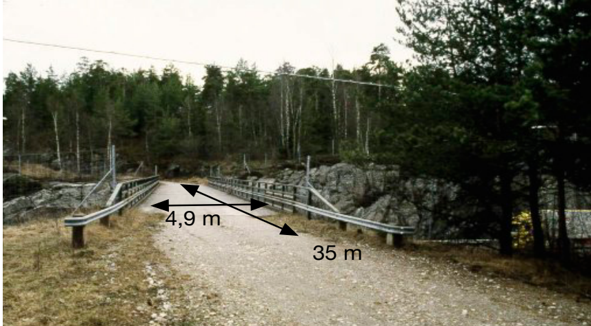
Figur 17. BaTMan Objekt 2-606-1: "Bro över E4 för enskild väg öster om Södertälje vid Hälsingland". Spårinventeringar visade att rådjur men även älg använde denna bro relativt ofta trots att övergången saknar siktskydd och djuren har fri sikt ner på den passerande trafiken. Passagen har en beräknad effektivitet på 25 % för älg och 31 % för rådjur. Foto: Andreas Seiler
