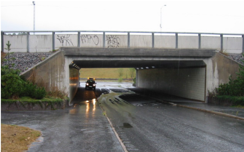
Figur 28. Bro 2-774-1: Bro under E4 över allmän väg. Bron är stor och rymlig och dessutom försedd med sikt/stängskydd, men passagen är upplyst och med stor sannolikhet för mycket trafikerad av både människor och fordon för att kunna fungera effektivt som viltpassage. Foto: ur BaTMan.
