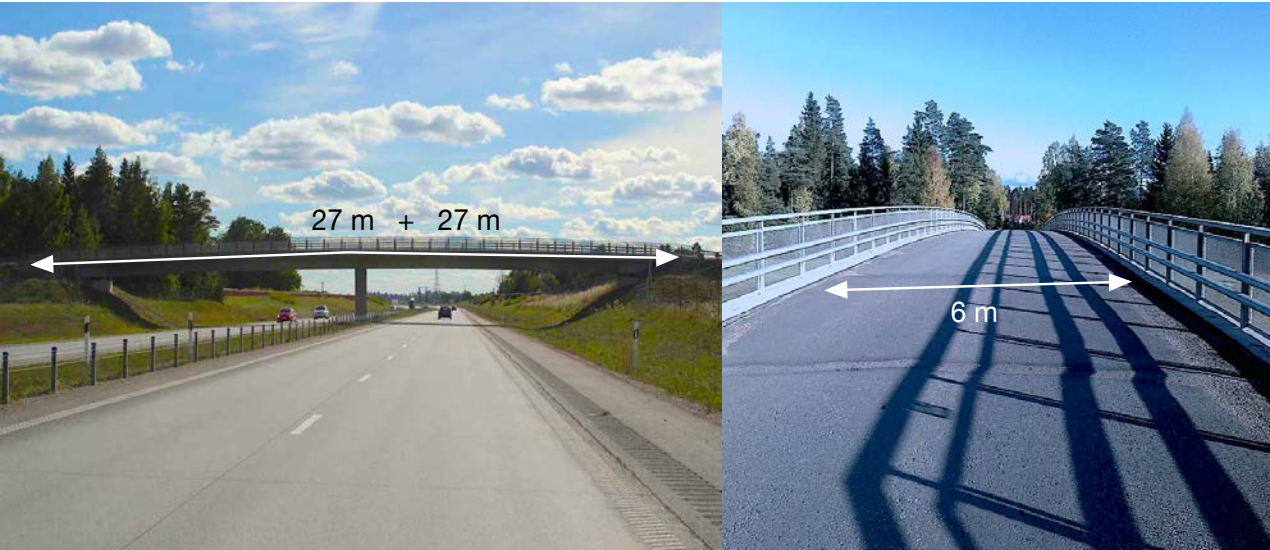
Figur 20. BaTMan Objekt 3-727-1: "Vägport för E4 under GC-väg vid Hämringe" inkluderas i den följande effektbedömningen. Bron är tillräcklig bred och relativt låg trafikerad, men samtidigt mycket lång och dessutom helt oskyddad mot trafikljus och buller från underliggande E4. Den erbjuder dock ingen effektiv passage, effektiviteten för klövvilt beräknas till enbart 12 %. Foto: ur BaTMan.
