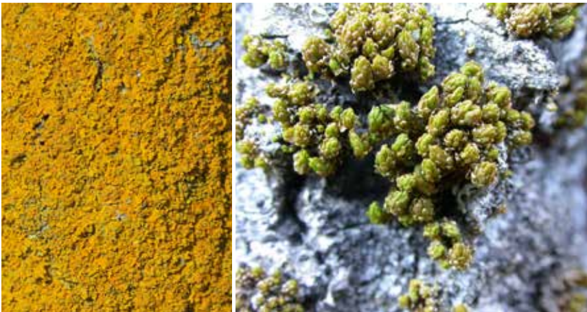
Till vänster: vägglav. Till höger: asphättemossa.
