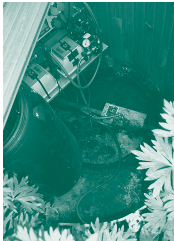
En befintlig slamavskiljare har här kompletterats med ett nedsänkt membranfilter. Det bakterie- och partikelbefriade vattnet pumpas sedan till den svarta plasttunnan, där fosfor sorberas till ett kalkhaltigt material. Anläggning hos Kurt Hansson, Norrby, Sala.
