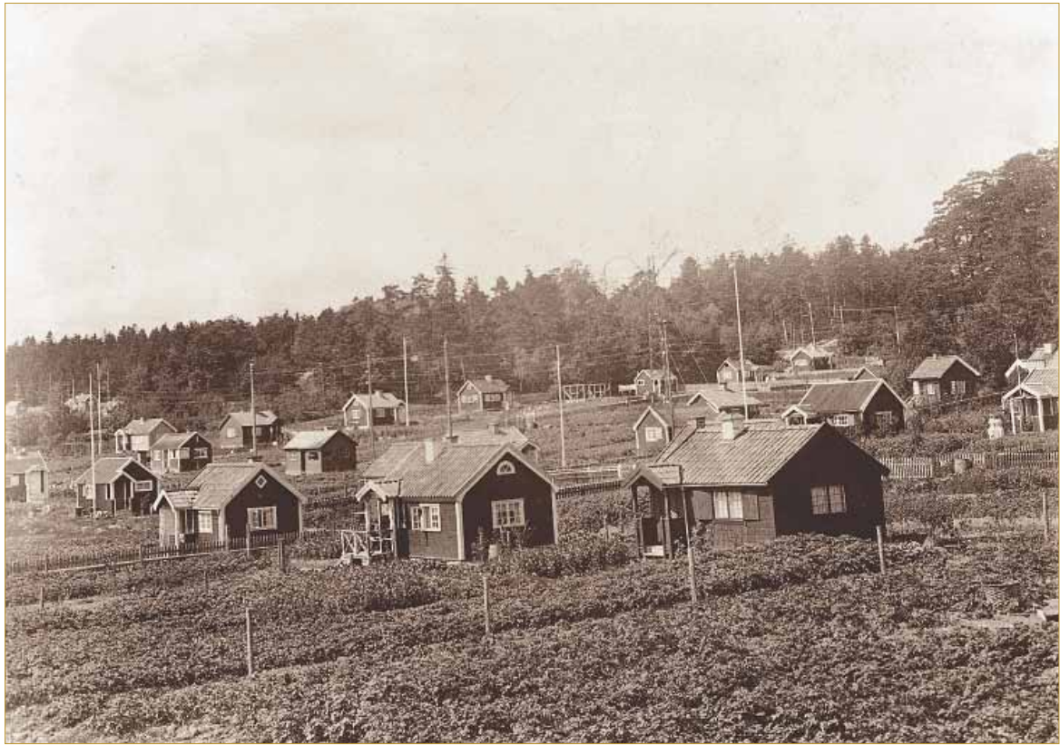
Bergshamra koloniområde i Solna anlagt 1919. Foto: Koloniträdgårdsförbundet.
