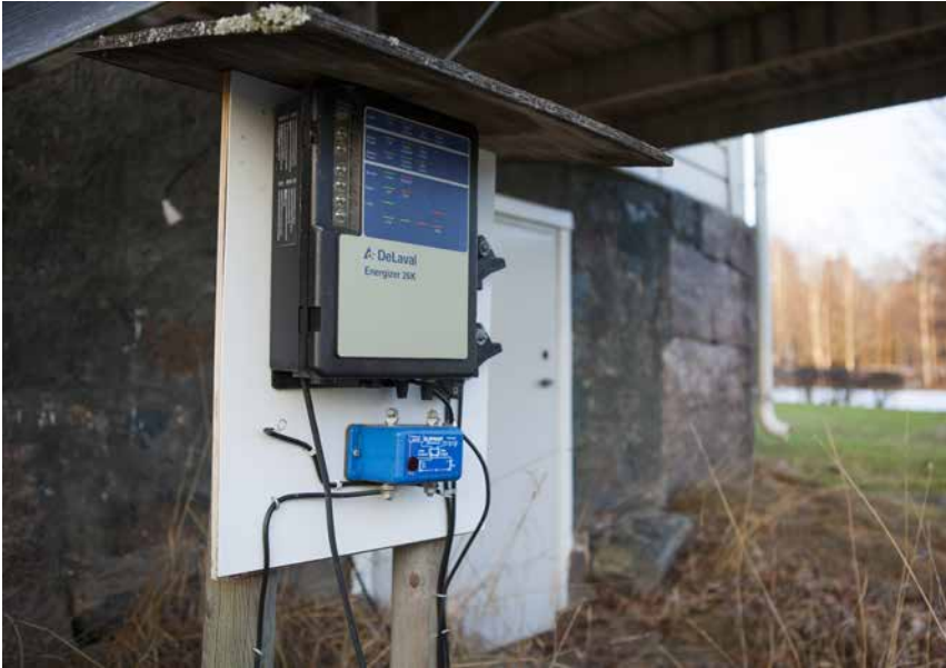
Bild 89. Elaggregat och åskskydd.
