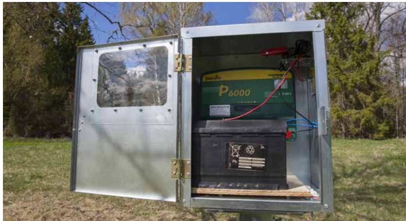
Bild 30. Plåtskåp för montering av batteriaggregat.
