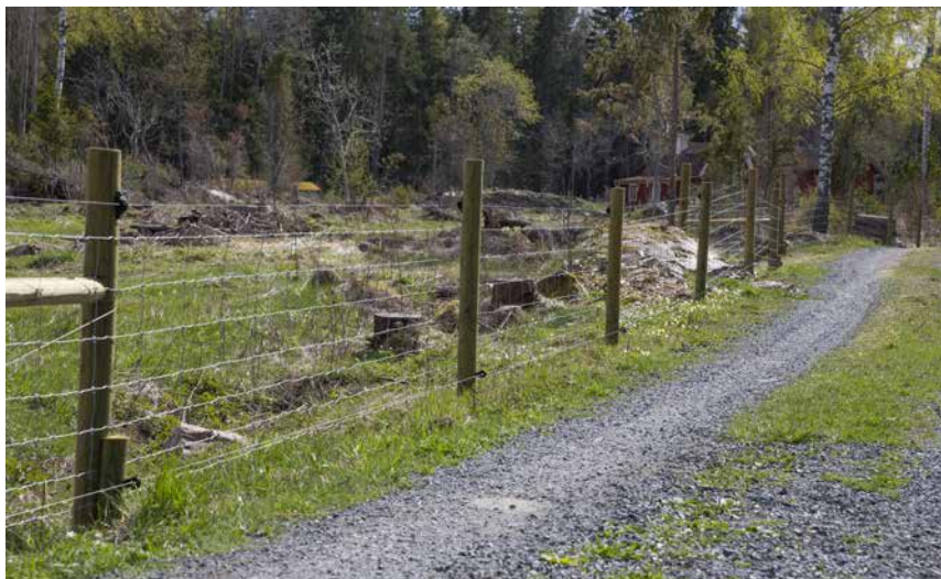
Bild 84. Fårnät kompletterat med två eltrådar, en hög ca 10 cm ovanför nätet och en låg ca 30 cm från marken. Den nedre tråden placeras inåt hagen mot fåren. På bilden är den dock monterad på utsidan.
