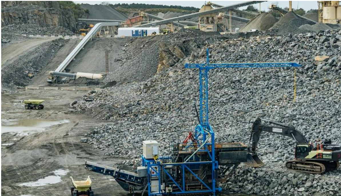
Figur 2. Två självgående och batteridrivna dumprar (tv) och en kabelansluten grävmaskin (th) från test- och demonstrationsprojektet Electric Site vid tänken Vikan utanför Göteborg.
