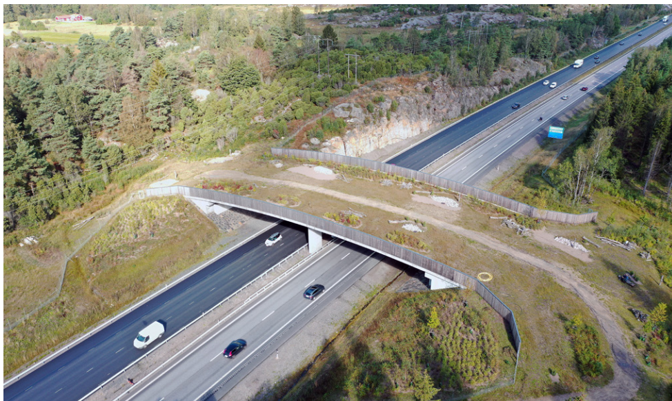
En ekodukt vid Sandsjöbacka naturreservat över E6/E20 utanför Kungsbacka. En djurvänlig passage över en tungt trafikerad väg som minskar landskapets fragmentering. Foto: Fredrik Winterås & Marcus Elfström, Enviro Planning AB (13 september 2019).
