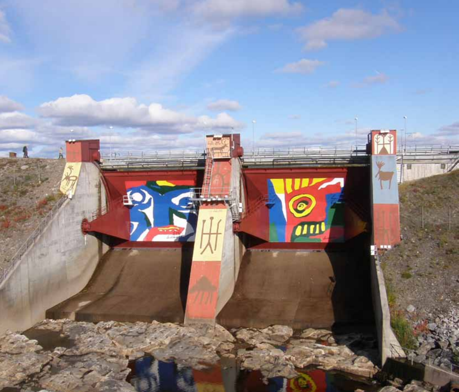
Vattenkraften hindrar vattenvägarna och skapar samtidigt osäkra isar, vilket skär av renarnas vandringsvägar. Här Akkats kraftverk strax norr om Jokkmokk. Foto: Håkan Tunón.
