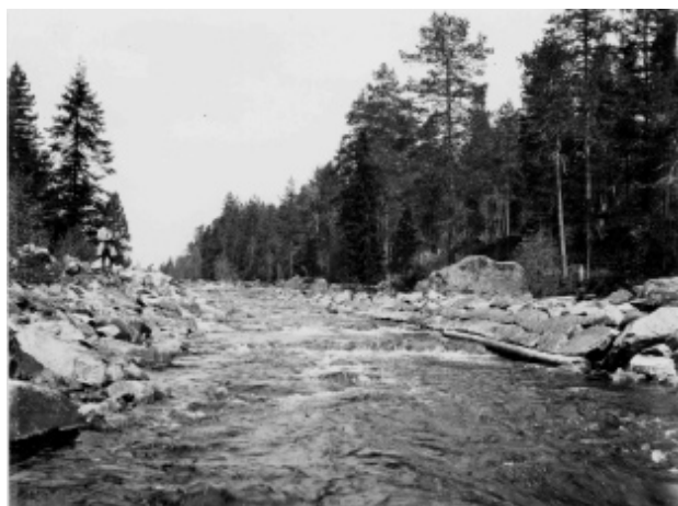
Flatån. Rensad del med stenledare av huggen sten. Bild från Skogsbibliotekets bildarkiv, SLU.
