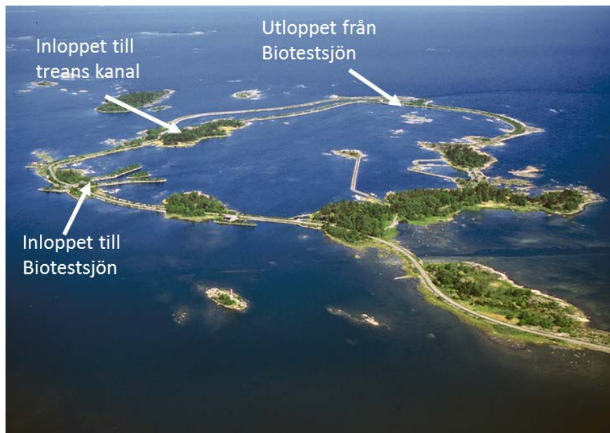
Figur 1. Biotestsjön sett söderifrån. Inloppet av kylvatten till anläggningen syns till vänster och utloppet till Öregrundsgrepen längst upp i bilden. Nordväst om inloppet syns inloppet av kylvatten från treans reaktor (F3).
