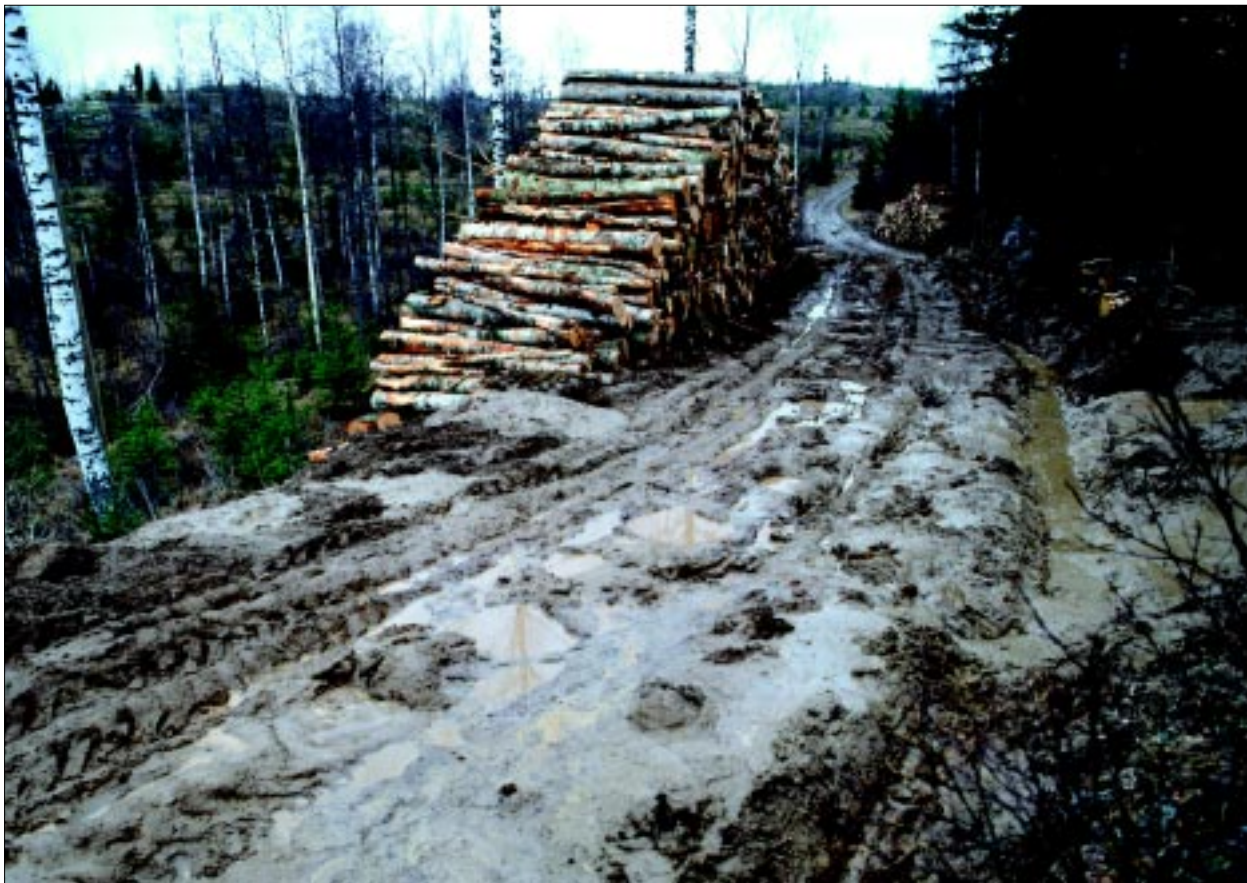
FIGUR 1. | Grusväg med urusel bärighet under tjällossningen.
