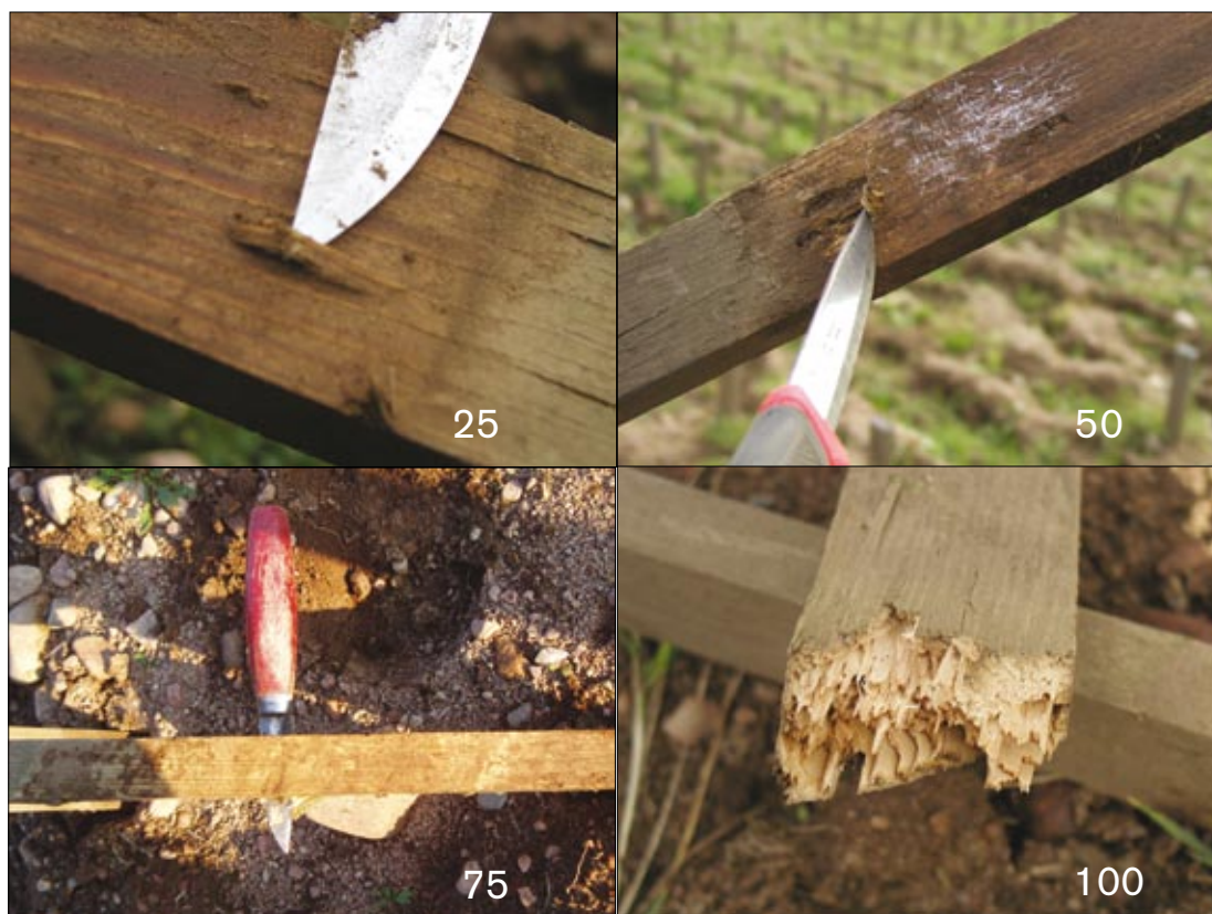
Figur 1. Utvärdering av stavars beständighet mot rötangrepp med hjälp av kniv. Rötindexet som lagts in i bilden visar rötans omfattning. Ett rötindex på 0 betyder att virket är fritt från röta medan ett index på 100 betyder att virket är kraftigt rotat och provet utdömt.
