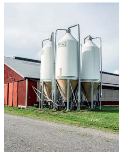
Kraftfodersilor som försörjer kraftfoderstationer.
