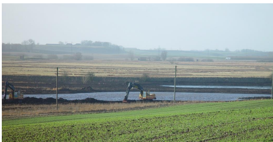
Fig 19. Skapande av nya våtmarker vid Torreberga söder om Staffanstop i Skåne. Foto: Urban Emanuelsson.
