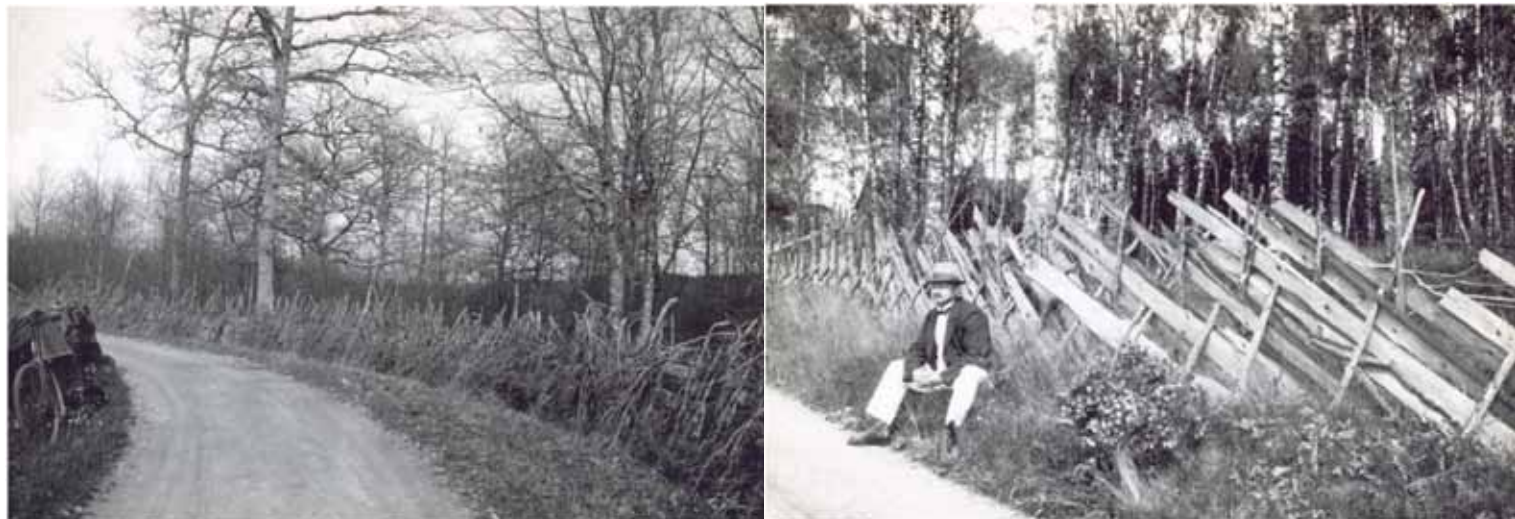
Olika hägnadstekniker beror på vilka material man har tillgång till och syftet med hägnaden. Bilden till vänster är från 1925 och skildrar en stengärdesgård armerad med enris i mellersta Skåne. Högra bilden skildrar ett skedgärde i byn Smedeboda som Sjöbeck besökte 1924. Ett skedgärde behöver varken hankar eller vidjor utan består av två meter långa kluvna stammar som hålls samman av käppar av ene. Foton: Helsingborgs museers samling.
