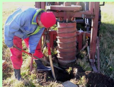
Fig.1 (↑). Nedsättning av mezonetrör.
