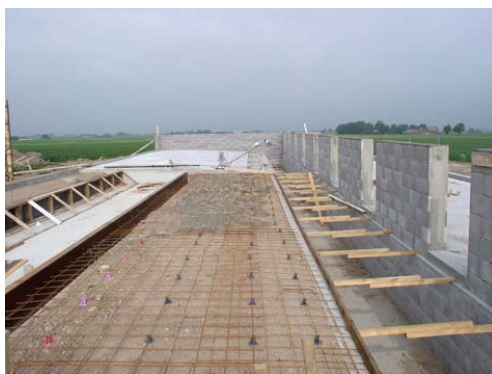
Figur 4. Ekologisk slaktgrisproduktion. Sidokanter till gödselrännor och väggar i stallet byggs upp med skalblock av betong. Blocken är ihåliga och armeras med armeringsjärn och fylls med betong.
