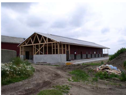
Figur 6. Ekologisk slaktgrisproduktion. Taket beläggs med fibercementplattor och väggarna kläs med glespanel av trä.
