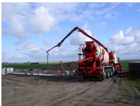
Figur 3. Ekologisk slaktgrisproduktion. Gjutning av grundplatta pågår.
