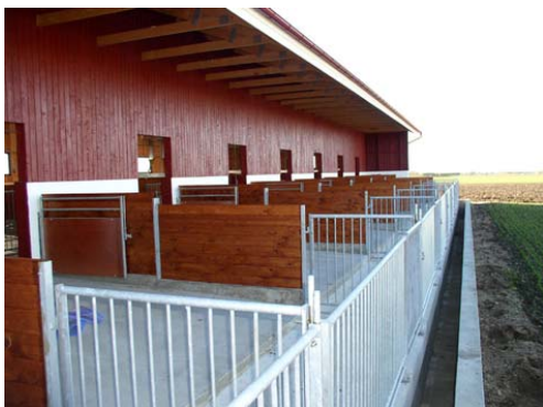
Figur 14. Ekologisk slaktgrisproduktion. Utomhus finns en rastgård som delvis är övertäckt av stallets tak. Betonggolvet på uteytan lutar i riktning mot en gödselkanal där gödsel och urin samlas upp.
