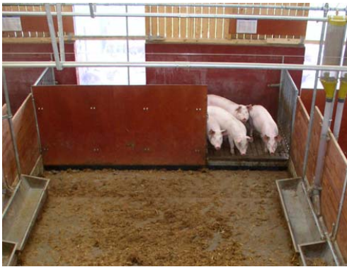
Figur 23. I ”straw-flow”-boxen finns en öppning mellan golvet på gödselytan och det upphöjda spaltgolvet i gödselgången.
