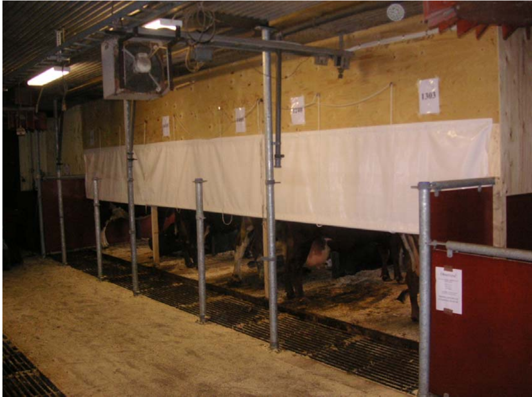
Figur 2. "Metanstugan" konstruerad för att få lägre bakgrundsvärden för metan kring båspallarna där metanmätning gjordes.
