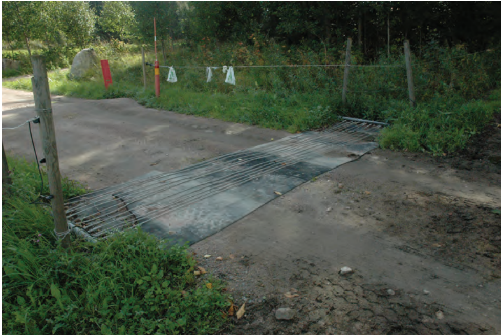
Elfäristen är ca 70 cm bred och ligger på var sida om kopassagen.
