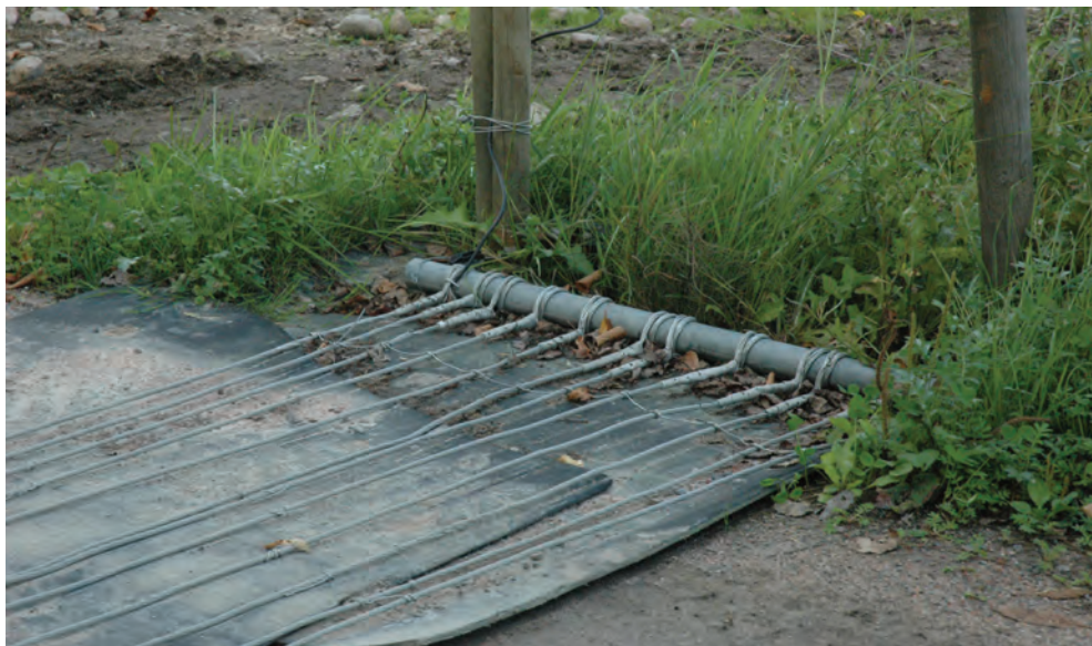
Den elektriska färisten är byggd av stålvarjrar som är strömförande över en gummimatta.
