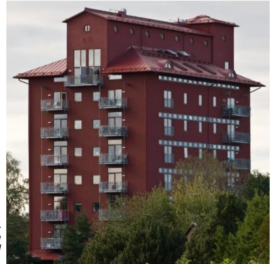
Tidigare spannmåls- magasinet i Eslöv från 1918, ombyggt till bostäder 2008.
