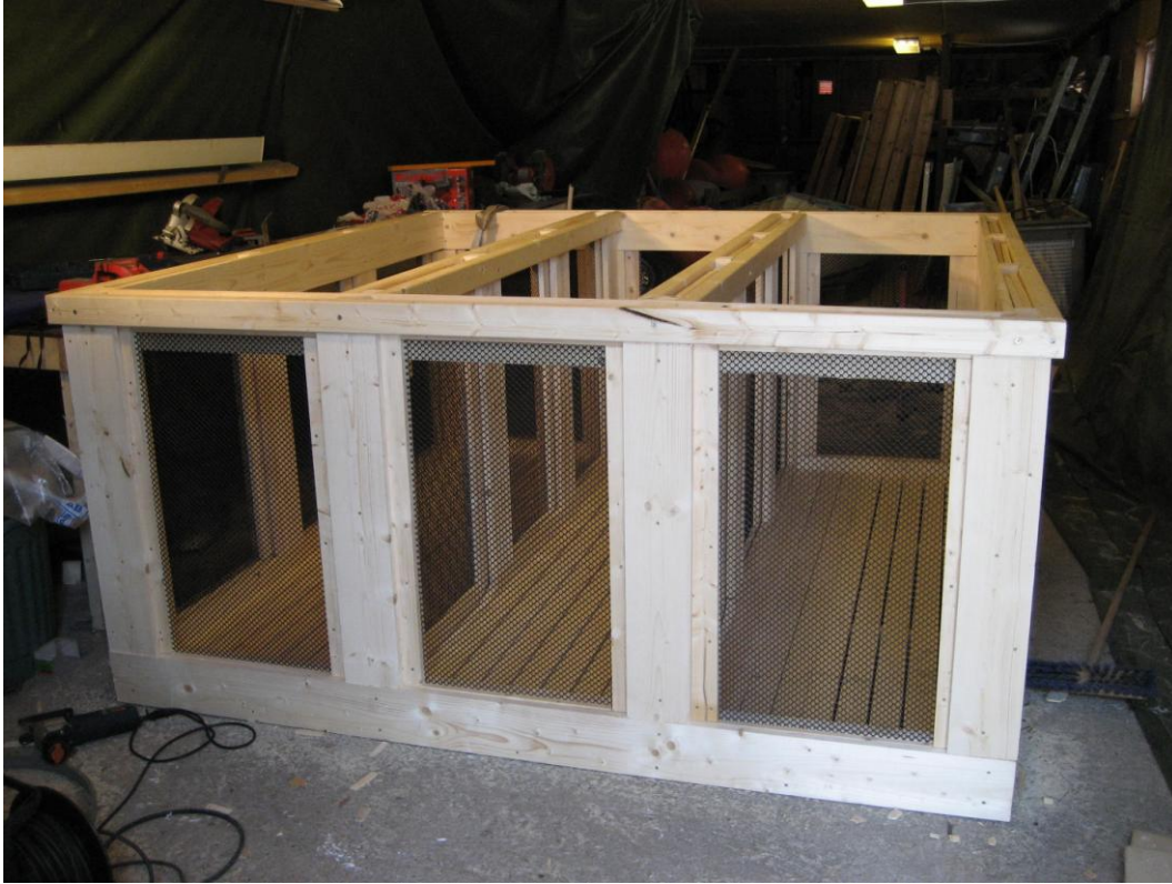
Figur 5. Smoltfällan som användes 2009-2010 innan den sattes i vattnet. Den ses från nedströmssidan. Fällans ingång ligger i mitten. Fisk som kom in i fällan simmade nedströms och flyttade oftast över till sidokanalerna, där strömhastigheten var mycket lägre.
