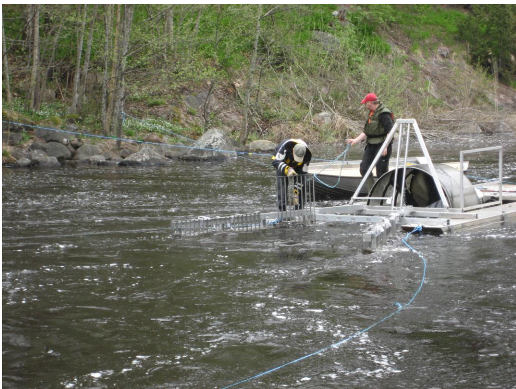
Figur 8. Bortmontering av galler på smolttrumman. Ställningen som höll gallren på plats monterades inte bort vid försök utan ledarm.
