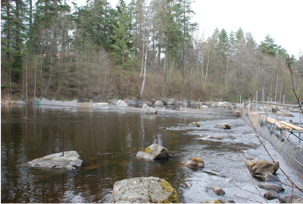
Figur 3. Smoltfällan med ledarmar är på plats. Längst borta till höger skymtar fällingången.
