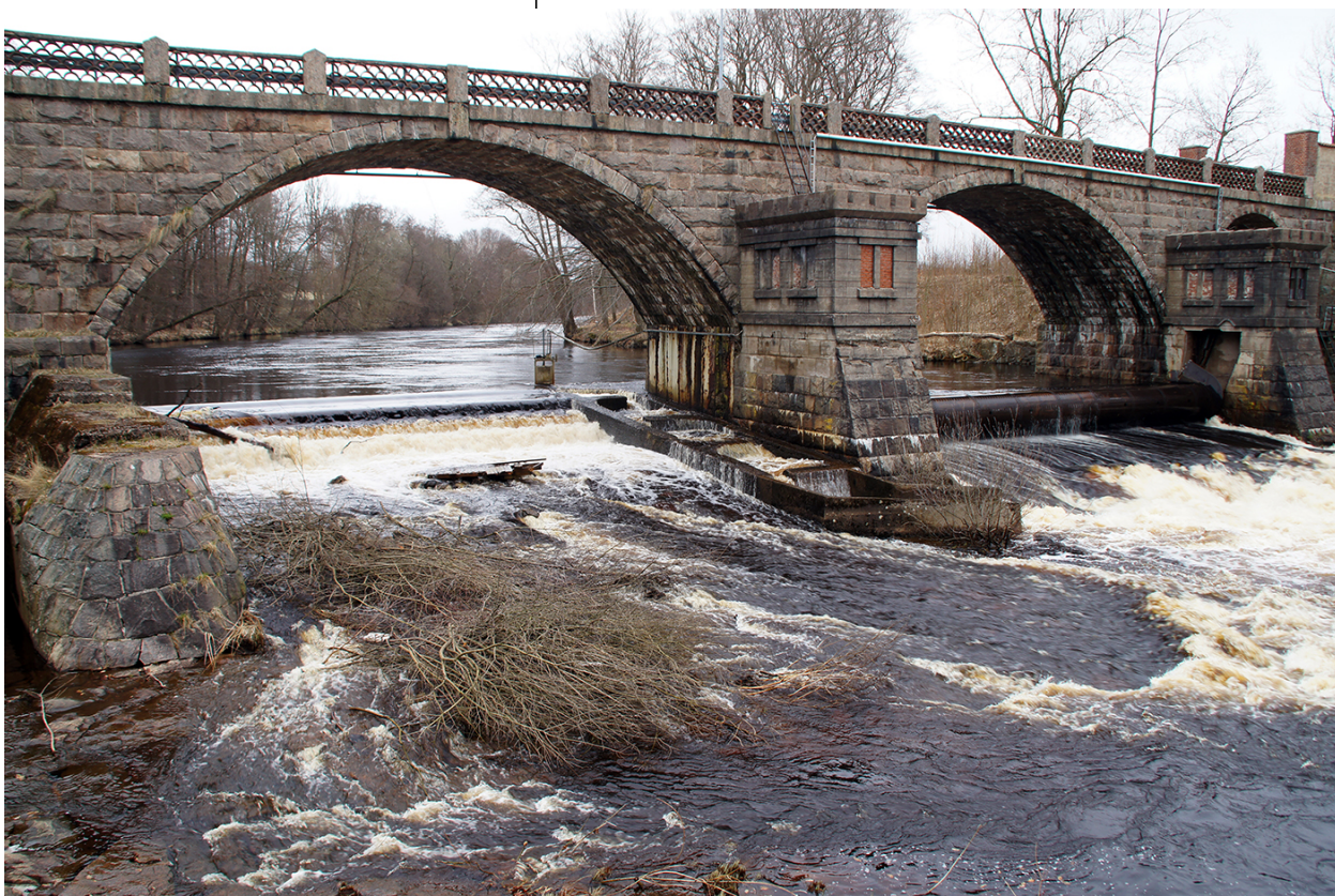
Nissans nedersta fiskväg vid Slottsmöllan, en av flera dåligt fungerande uppströms passager.
