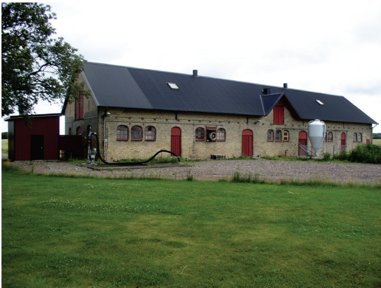
Bild 2: Stallet med det tillbyggda huset för skrubbern.
