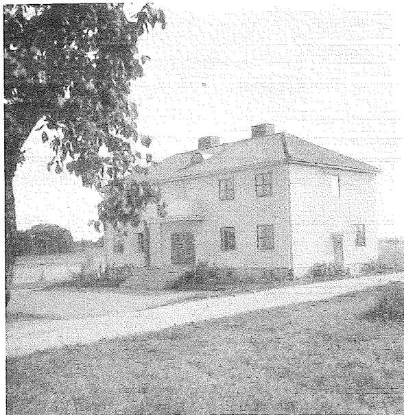
I denna byggnad å Tornby, Linköping, inrymmas filialer av Sveriges utsädesförening och Statens växtskyddsanstalt.
