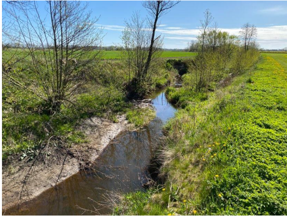
Tvästegsdike utanför Varberg (vänster) och Nyköping (höger)
