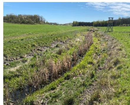
Tvästegsdike utanför Gamleby
