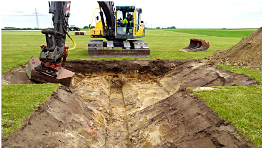
Bild 1. Demonstrationsgrävning av ett vanligt dike i förgrunden och ett tvåstegsdike. Foto: Zivko Rasic.
