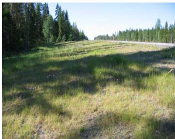
Bild 13. Utflackad slänt helt utan botaniska värden gräsfrö insått. (Väggkant vid infart till Ulriksfors)
