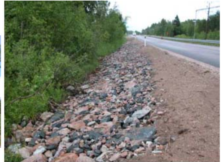
Grovt stenkross i slänt.
