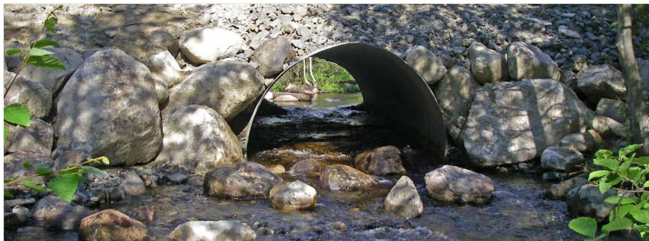
Genom att byta ut cementrör mot halvtrummor möjliggör man spridning av fisk och andra djur i vattendragen. Foto: Andreas Karlberg.
