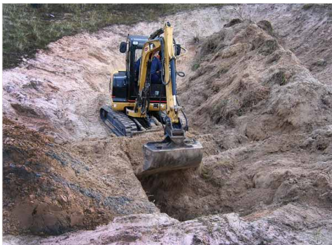
I dynsänkan har ljung, kråkris, tall och björk tagit över; öppen sand finns bara i stigen som leder förbi. En mindre bandgrävare skalar av vegetationen från kanten intill mitten. I mitten grävs ny sand upp och hamnar i en hög för sig. Den avskalade vegetationen läggs i graven och den oförsurade sanden sprids ovanpå. En ny dynsänka har skapats med 200–300 m 2 öppen sand. Efter en vecka har maskinspårerna slätats ut. Foto: Kill Persson.
