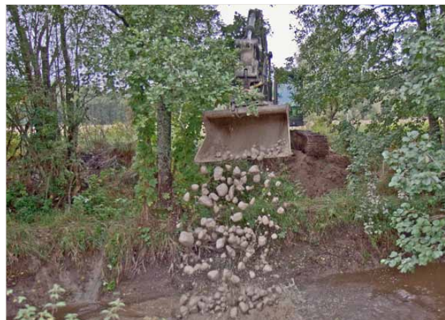
läggning av sten i en kraftigt rensad del av Kilaån, Södermanland. Foto: Ursula Zinko.
